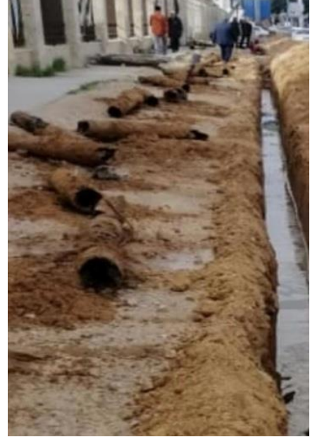
شكل 4: التسرب من شبكات المياه بمدينة زليتن (لجنة زليتن، 2024)
