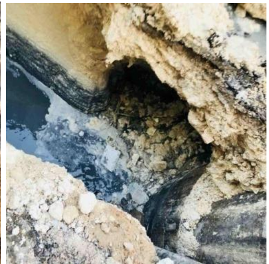
شكل 5: تسرب مياه الصرف الصحي نتيجة لتلف الأنابيب (أمهني والنعاس، 2019).
